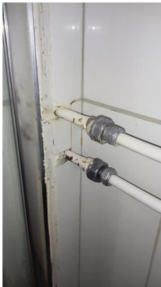
Våtrom - [Rørgjennomføringer i dusj]
