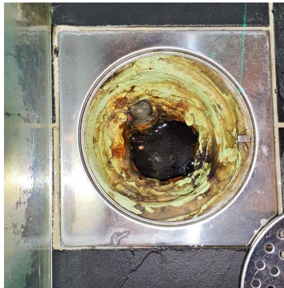
Våtrom - [Sluk bad]
