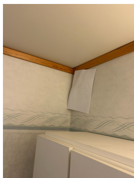
Papirark test på avtrekksventil.
