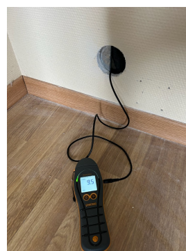
Hulltaking i tilstøtende konstruksjon.
