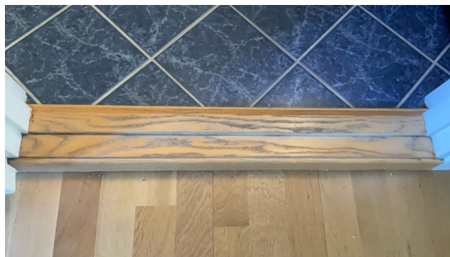
1. ETASJE Utleiedel > BAD
