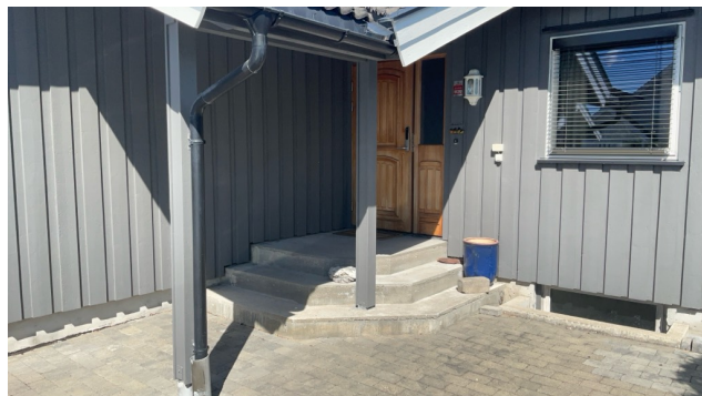
Hovedinngang med støpt trapp.
