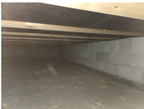
Bilde fra krypkjeller, tatt fra vindusåpning.
