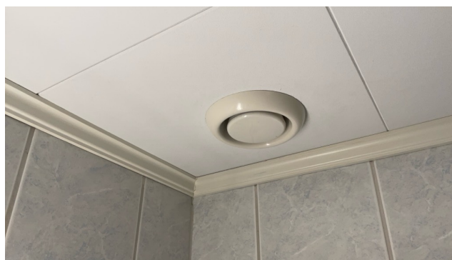
1. ETASJE UTLEIEDEL > BAD
