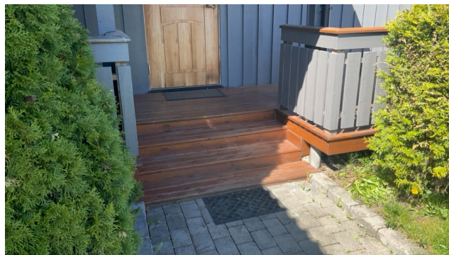
Utleide med trapp av impregnerte materialer.
