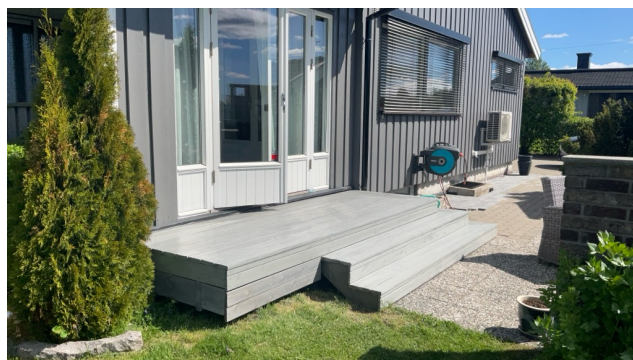
Hoveddel på verandatrapp av impregnerte materialer.
