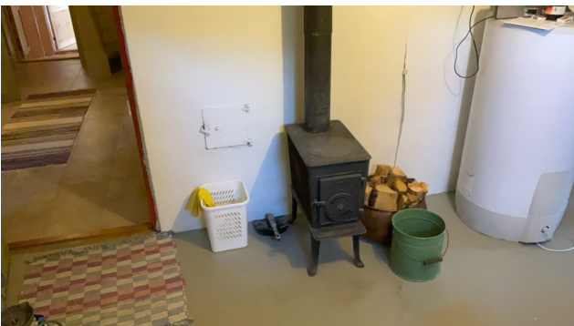
Vedovn og feieluke 2 i kjeller.
