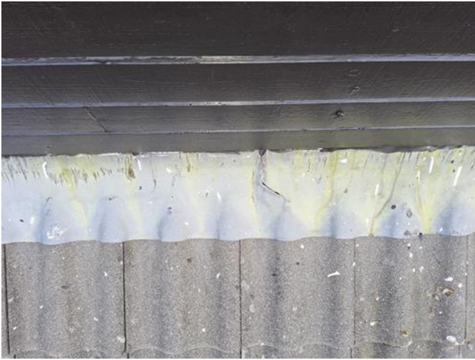
Yttertak - [Slitasje på beslag/takstein. ]
