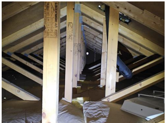
Loft - uinnredet / råloft - [Kaldtloft]
