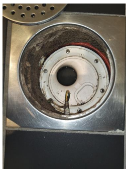
Tettesjiktets tilslutning til sluk - Sluk bad
