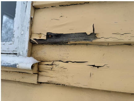
Råteskader i panel og dekkbord rundt vinduer
