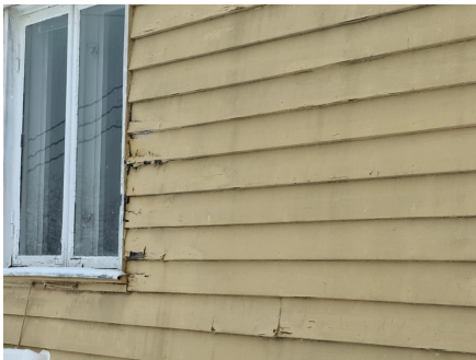
Råteskader i panel og dekkbord rundt vinduer
