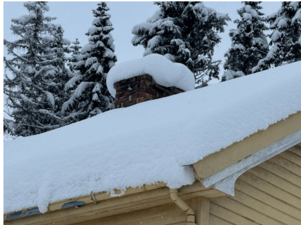
Snø på tak ved befaring
