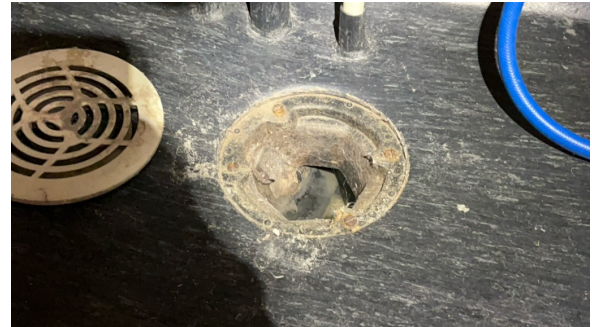
Kontroll av sluk.
