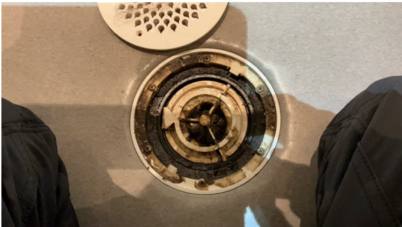
Kontroll av sluk.
