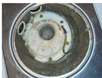
Tettesjiktets tilslutning til sluk - Hovedsluk
