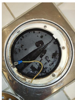
Tettesjiktets tilslutning til sluk - Hjelpesluk
