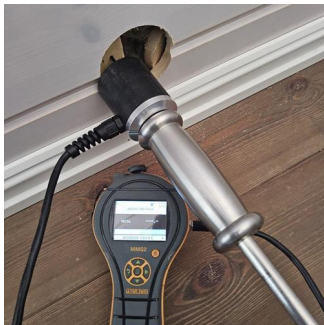
Utført kontroll i tiliggende konstruksjon - Fuktmåling bad 1
