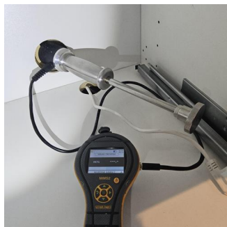
Utført kontroll i tilleggende konstruksjon - Fuktmåling bad 2
