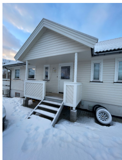
Manglende rekkverk utvendig trapp
