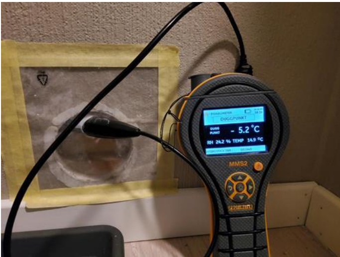
Kommentar - [Fuktmåling bad.]
