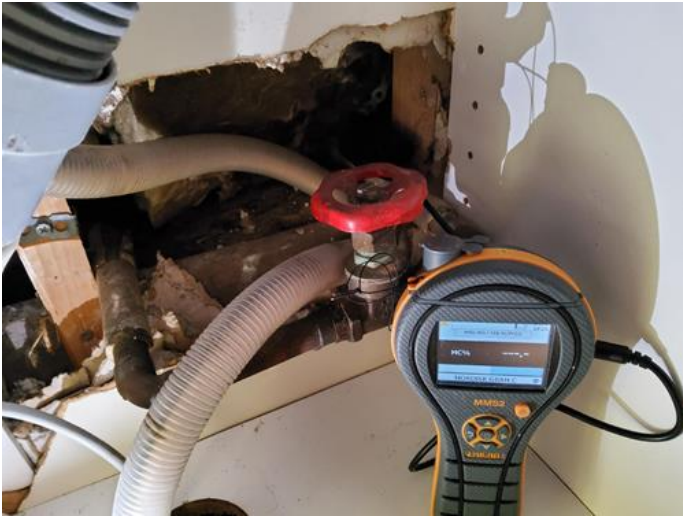
Kommentar - [Fuktmåling konstruksjonen under kjøkkenvask.]
