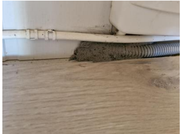
Ledningsgjennomføring sikret
