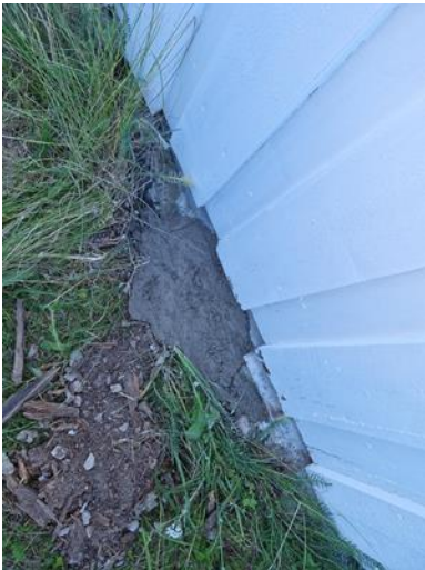
Utvendige hull i bakken ble fylt med betong
