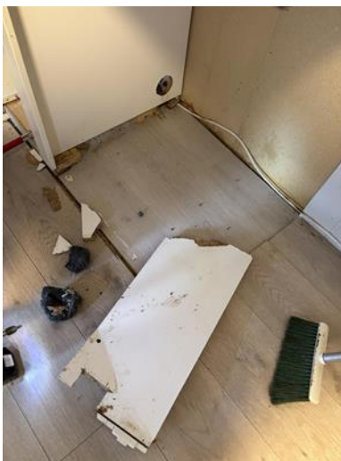
Bunnplate i kjøkken demontert og byttet
