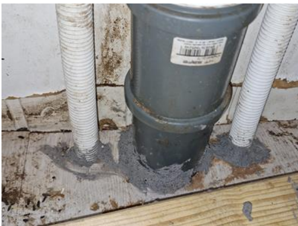
Rørgjennomføringer sikret
