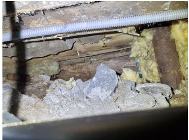
Musebord på krone fjernet og sprekk sikret
