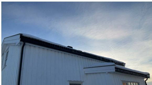
Taktekking var dekket med snø på befaringsdagen.
