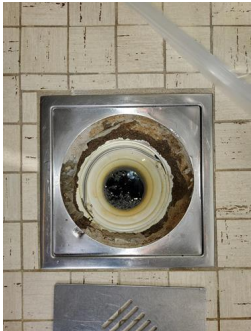
Tettesjiktets tilslutning til sluk - Sluk Baderom.
