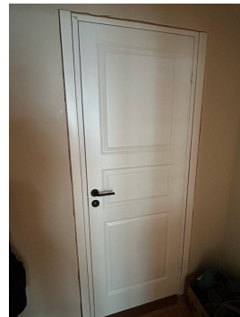
Dør mangler utføringer og lister
