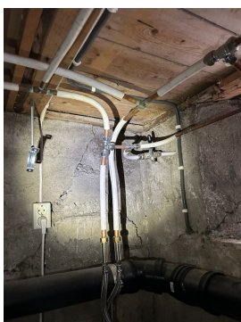
Vannledninger av kobber med plastkappe.
