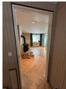
Dør mangler utføringer og lister
