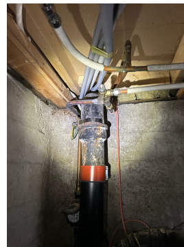
Overgang fra plastrør til støpejernsrør.
