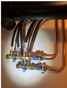
Vannledninger av kobber med plastkappe.
