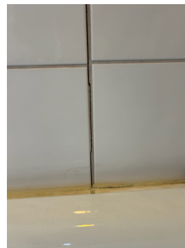
Oppsprukket flisefuge i våtsone.
