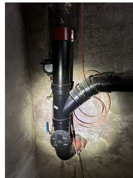
Overgang fra støpejernsrør til nyere plastrør.
