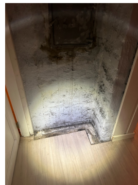
Manglende plate på gulv under sotluke.
