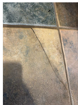
Oppsprukket flisefuge i våtsone.
