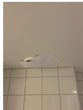
Avtrekkventil funksjonstestet med papirark.
