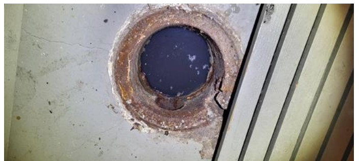
Våtrom - [Sluk i vaskekjeller]
