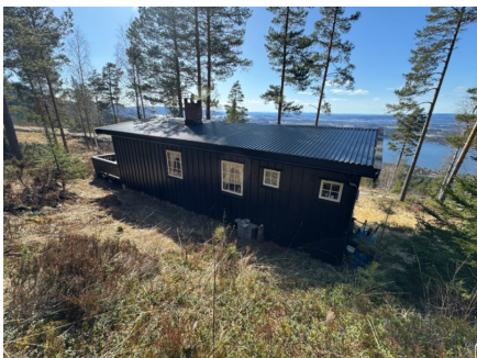
Åpen fundamentering med pilarer
