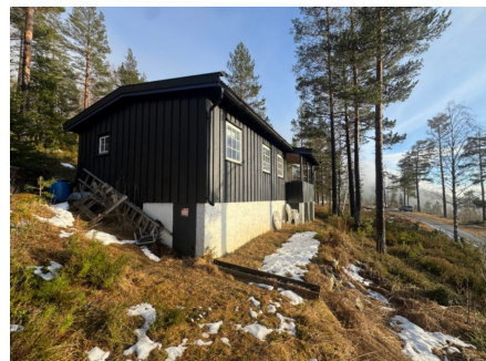
Leca grunnmur for deler av hytte
