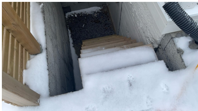
Impregnert trapp i utvendig kjellernedgang.
