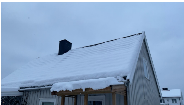
Snøsmelting langs del av møne.
