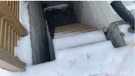
Impregnert trapp i utvendig kjellernedgang.
