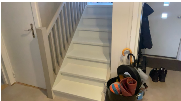
Trappedel til 2. etasje.
