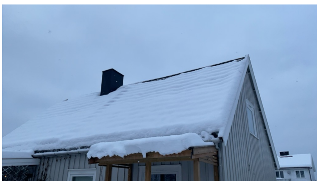
Snøsmelting langs del av møne.
