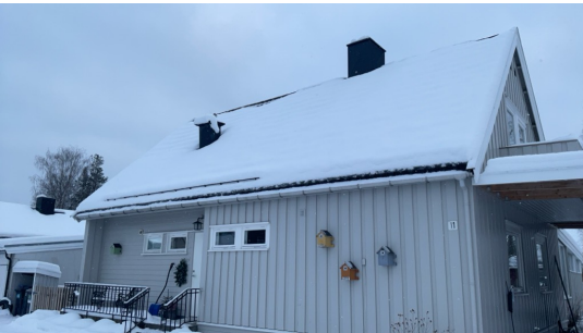
Snødekket tak ved befaringen.
