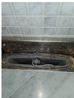
Tettesjiktets tilslutning til sluk - Sluk bad
