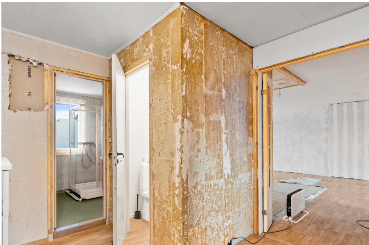
Gang med inngang til separat toalett og bad.
