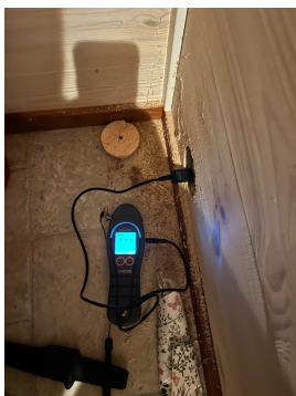
Hulltaking i tilstøtende konstruksjon.
