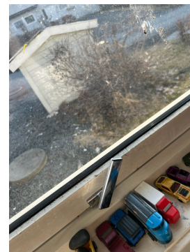
Tydlig tegn på innvendig kondensering.
