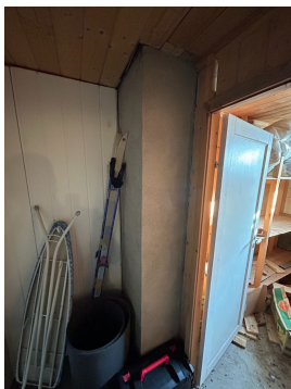
Avstand mellom sotluke og brennbart materiale er for liten.
