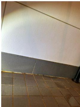
Fuge mellom bunnskinne og baderomsplate fremstår som ufullstendig, samt mye svartesopp.
