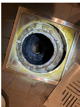
Synlig membran under klemring i sluk.
