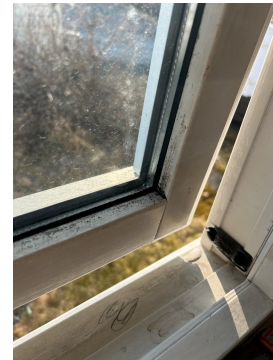
Tydlig tegn på innvendig kondensering.
