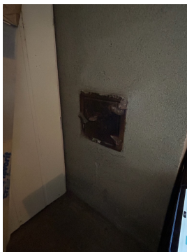
Avstand mellom sotluke og brennbart materiale er for liten.
