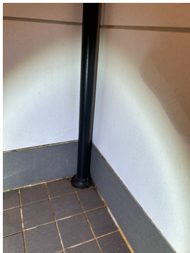
Fuge mellom bunnskinne og baderomsplate fremstår som ufullstendig, samt mye svartesopp.
