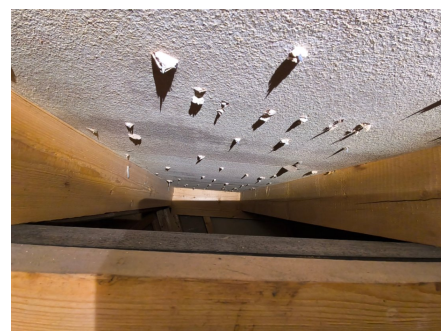
Spiker stikker gjennom undertak.
