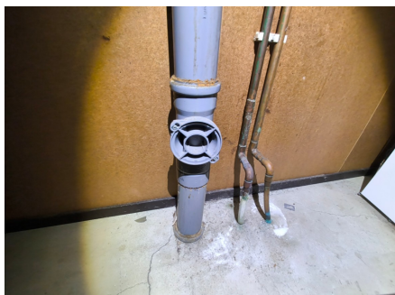
Stakeluke vaskerom i kjeller.
