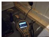
Utført kontroll i tiliggende konstruksjon - Fuktmåling bad.
