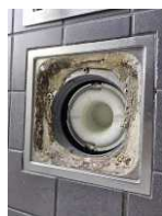
Tettesjiktets tilslutning til sluk - Sluk i bad.
