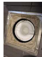
Vanntett sjikt / membran - Sluk i teknisk rom.
