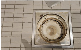
Tettesjiktets tilslutning til sluk - Sluk i dusjsonen.
