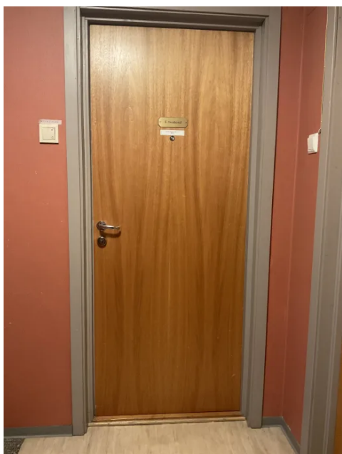
Finert ytterdør med brann-/lydklassifisering B30
