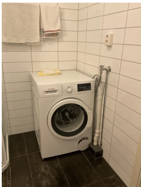
Bad med opplegg for vaskemaskin
