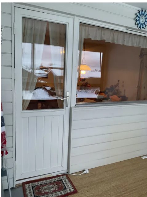
Malt terrassedør med isolerglass
