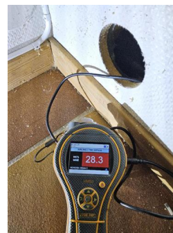
Kontroll i lukkede konstruksjoner - Fuktmåling.
