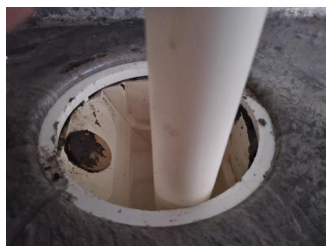
Tettesjiktets tilslutning til sluk - Sluk.
