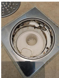
Tettesjiktets tilslutning til sluk - Sluk.
