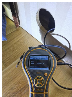
Utført kontroll i tilliggende konstruksjon - Fuktmåling.
