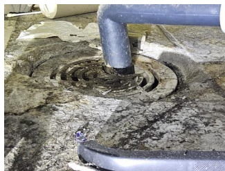
Tettesjiktets tilslutning til sluk - Sluk under dusjkabinett.
