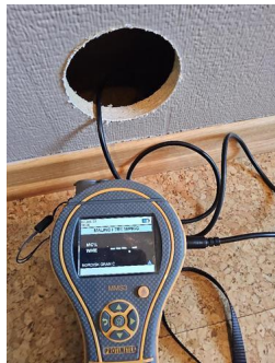
Utført kontroll i tilliggende konstruksjon - Fuktmåling.
