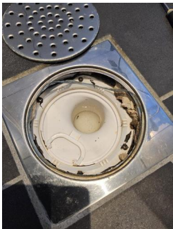
Tettesjiktets tilslutning til sluk - Sluk.
