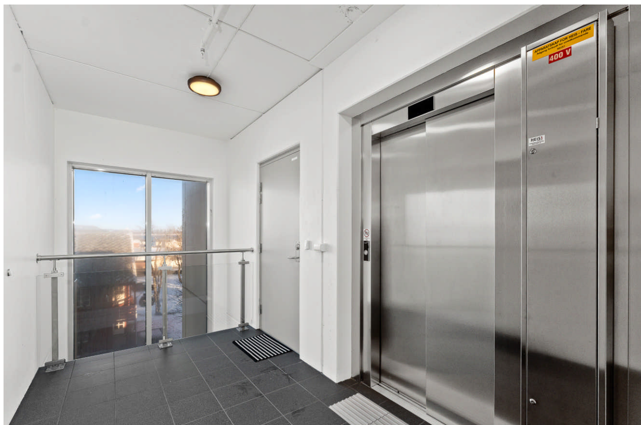
Heis i bygget
