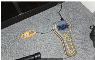
Utført kontroll i tilliggende konstruksjon - Fuktmåling i tilliggende konstruksjoner.
