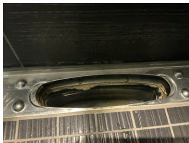
Sluk i dusjsone.
