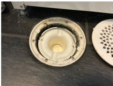
Bildet av sluk inne på vaskerom.
