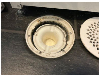
Bildet av sluk inne på vaskerom.
