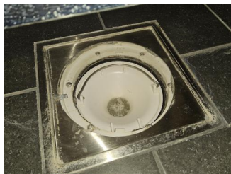
Tettesjiktets tilslutning til sluk - Sluk bad
