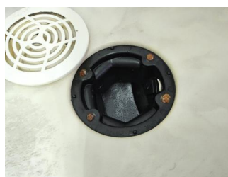
Tettesjiktets tilslutning til sluk - Sluk.
