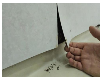
Overflater vegger - Plater i dusjsonen.
