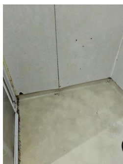
Overflater vegger - Plater i dusjsonen.
