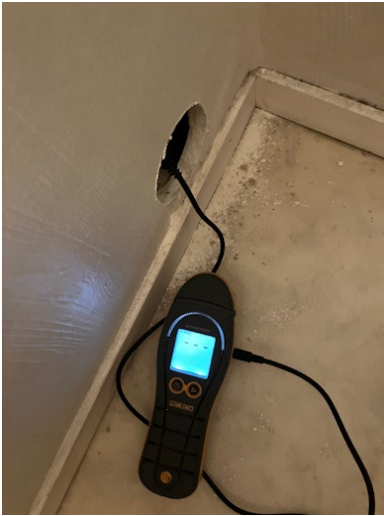
Bilde av fuktsøk via hulltaking uten at det påvises fukt.
