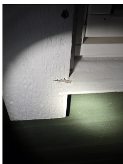
Omramming lagt ned på vannbrettet.
