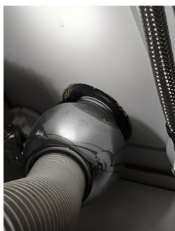
Rørgjennomføring i vegg under servant (våtzone).
