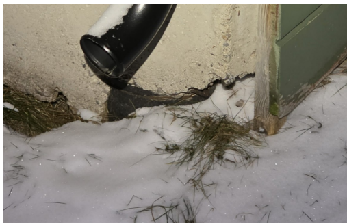
Grunnmur synes å bæres av støpte søyler.
