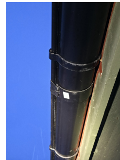
Takrenne observert fra veranda.
