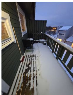
Snødekke på befaringstidspunktet.
