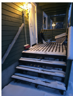
Snødekke på befaringstidspunktet.
