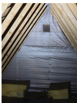
Plastsjikt montert på gavlvegg mot vest.
