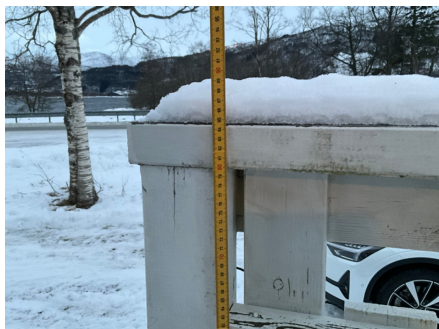
84,5 cm høyt rekkverk terrasse.
