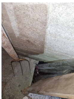
Bildet viser åpning ned mot grunn.
