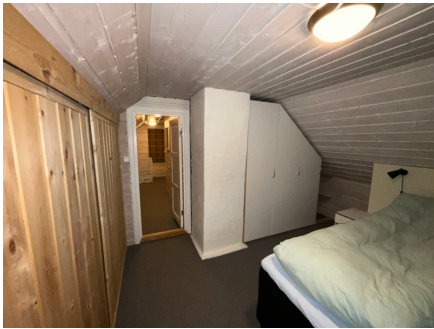
Dør inn til soverom 1 tar i karm/terskel
