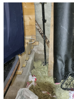
Bildet viser vegg påforet med terrassebord
