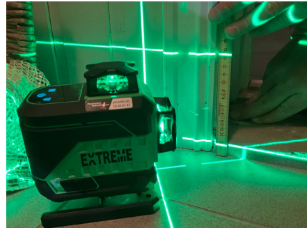
Bildet viser topp gulv ved dørterskel mot kjøkken.
