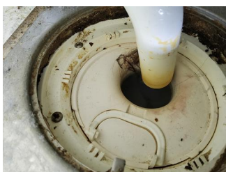
Tettesjiktets tilslutning til sluk - Sluk i bad.
