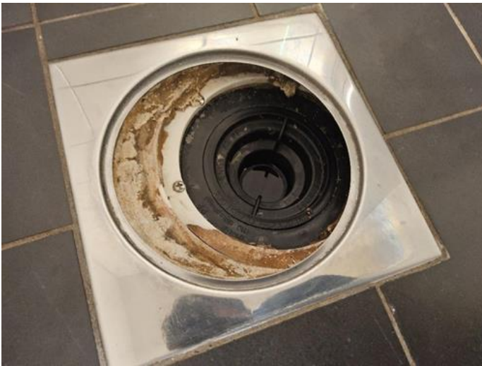
Våtrom - [Sluk på bad (dusjsonen).]
