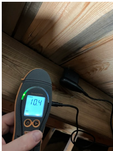
Bilde av fuktsøk i selve takkonstruksjonen.
