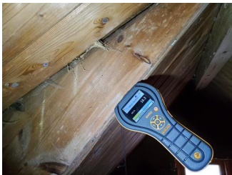
Synlige overflater (taktro, vegger, gulv, o.l) - Fuktmåling trekonstruksjoner i kaldtloft.
