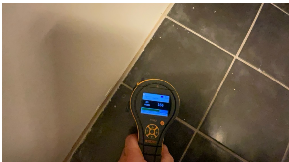
Fuktsøk er utført på gulv i dusj mot yttervegg . Ingen forhøyde fuktavvik er målt
