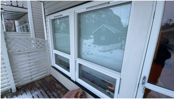
Vindu på stue
