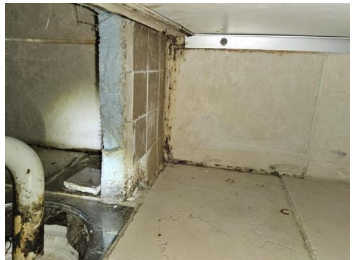
Overflater vegger - [Vegg under servanttinnredning ]
