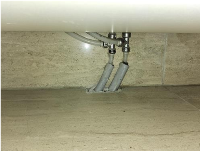
Membran, tettesjikt og overgang til sluk. - [Vannrør bad 1.etasje ]
