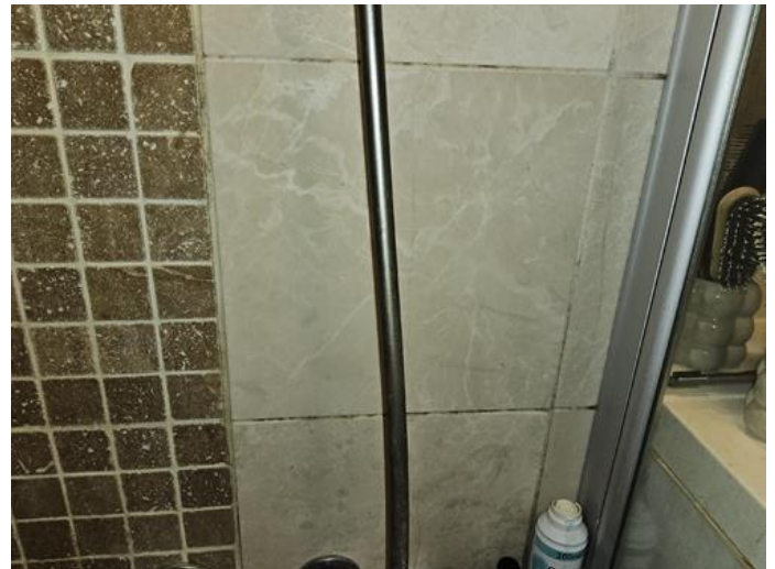
Overflater vegger - [Fuger bad underetasje ]
