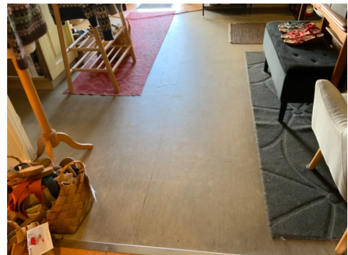
Slitasje på wc rom
