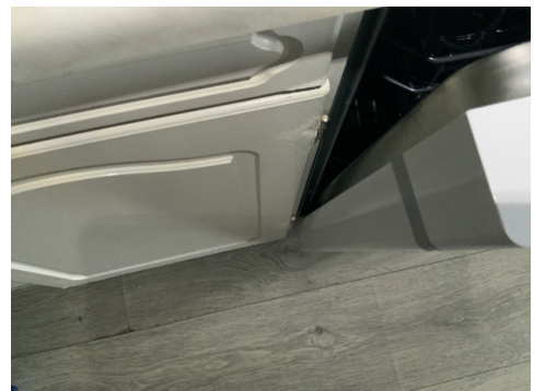
Svellemerker-fuktskade
