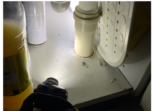
Svellemerker-fuktskade
