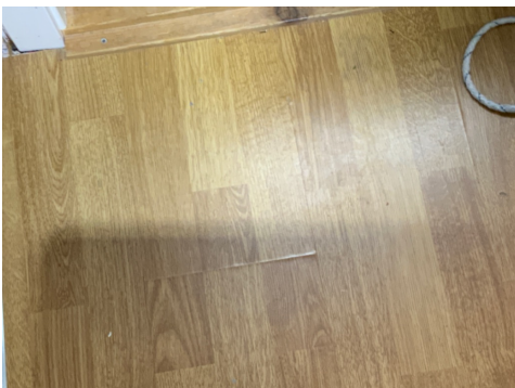
Svellemerker laminatgulv
