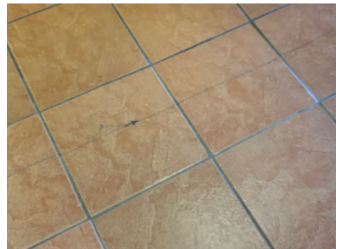
Sprukkede fliser med hulrom under.
