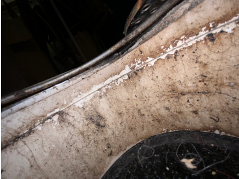
Ikke synlig gulvmembran
