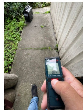
Terreng og deler av plattinger heller inn mot husvegg og tilbygg/kjøkken.
