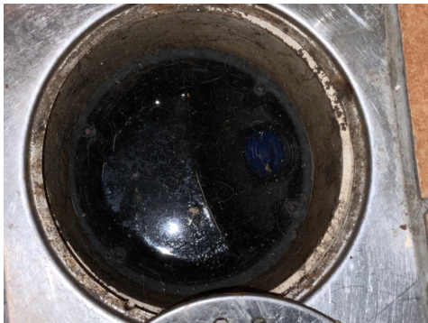
Ikke synlig gulvmembran
