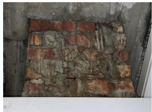
Rennermerker etter sotvann og ikke oppfylte fuger
