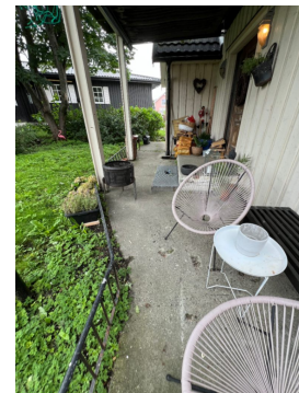
Terreng og deler av plattinger heller inn mot husvegg og tilbygg/kjøkken.
