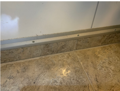
I overgang vegg-gulfliser er det montert feil type list samt at det er skrudd/punkttert membran en del plasser i våt sone. Ufagmessig montert. Større risiko for utett løsning
