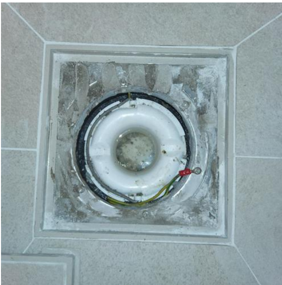
Våtrom - [Sluk bad kjeller]
