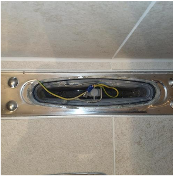
Våtrom - [Sluk bad 2.etasje]
