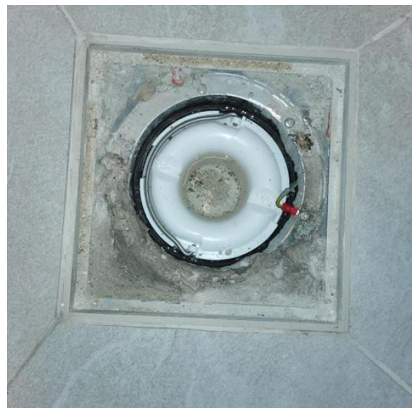
Innvendig - [Sluk vaskerom]
