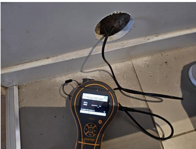
Våtrom - [Fuktmåling bad 1.etasje ]
