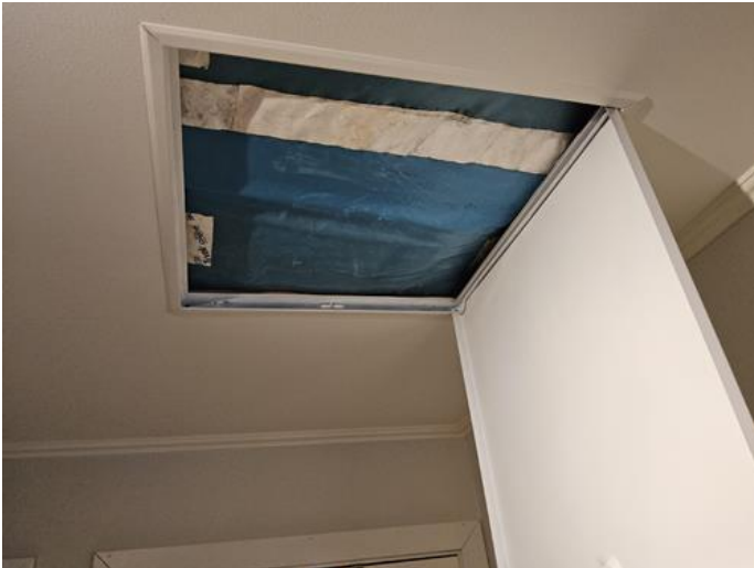
Loft - uinnredet / råloft - [Ikke tilkomst til uinnredet kaldtloft]
