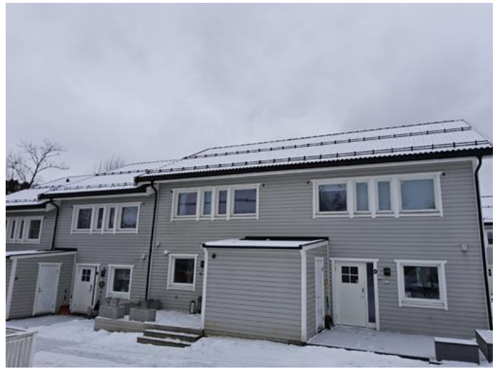
Yttertak - [Snødekket yttertak ]
