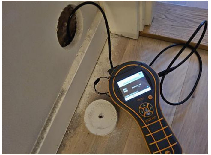
Våtrom - [Fuktmåling bad 2.etasje ]
