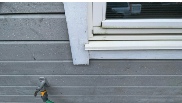
Listring av vinduer
