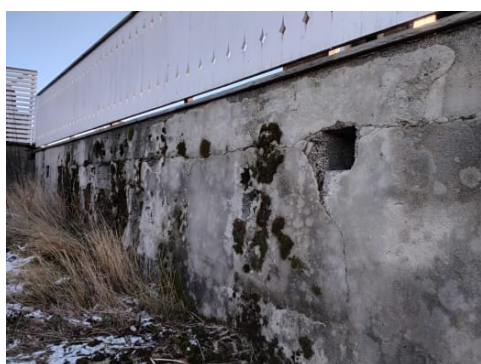
Ringmur under dler av terrassen.
