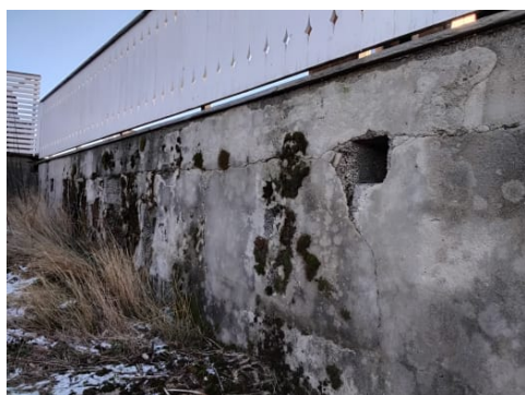
Ringmur under dler av terrassen.
