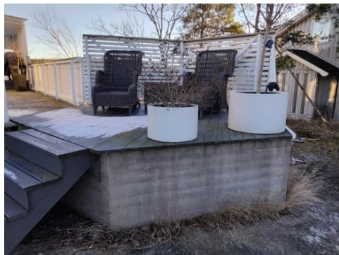
Manglende rekkverk.
