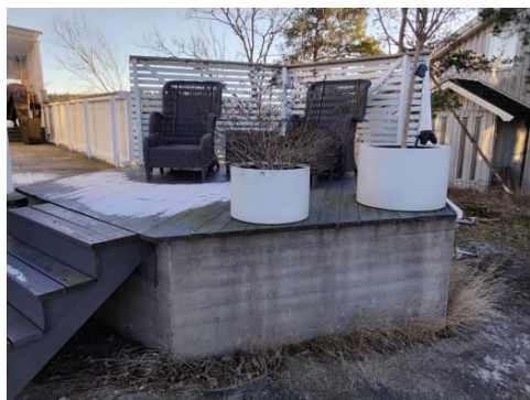
Manglende rekkverk.
